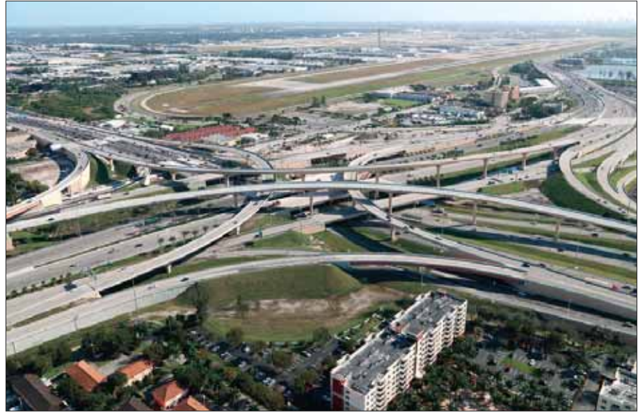
USA CONDOTTE Svincolo autostradale
