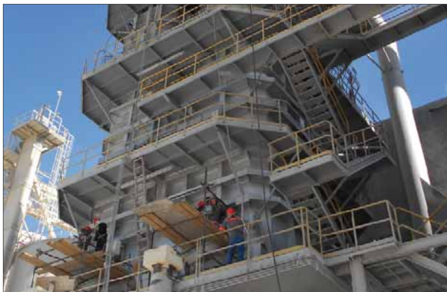
MESSICO FERRETTI INDUSTRIAL SERVICES Costruzione industriale
