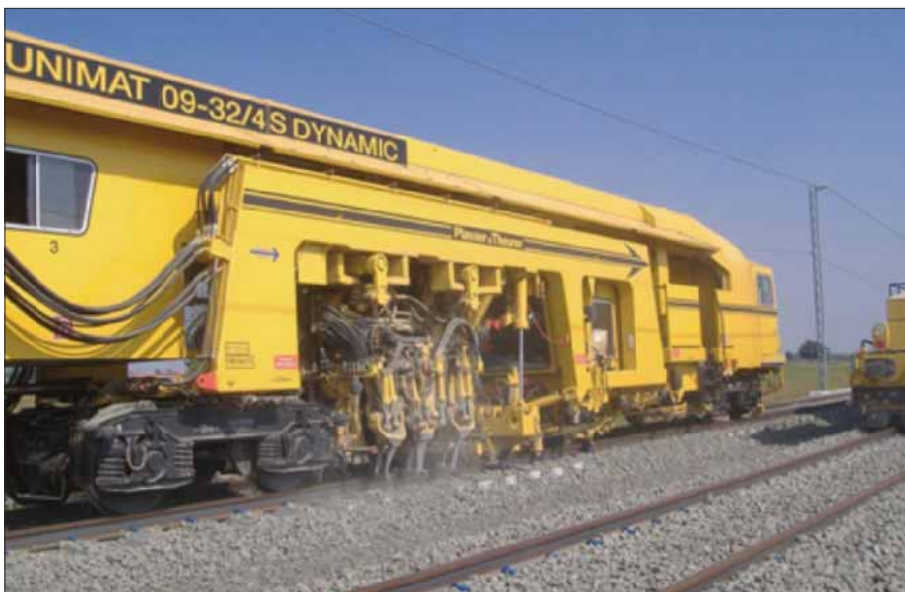
BULGARIA CLF Costruzione linea ferroviaria
