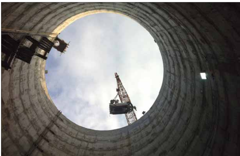
MALESIA EDILMAC Pozzo per Centrale Idroelettrica
