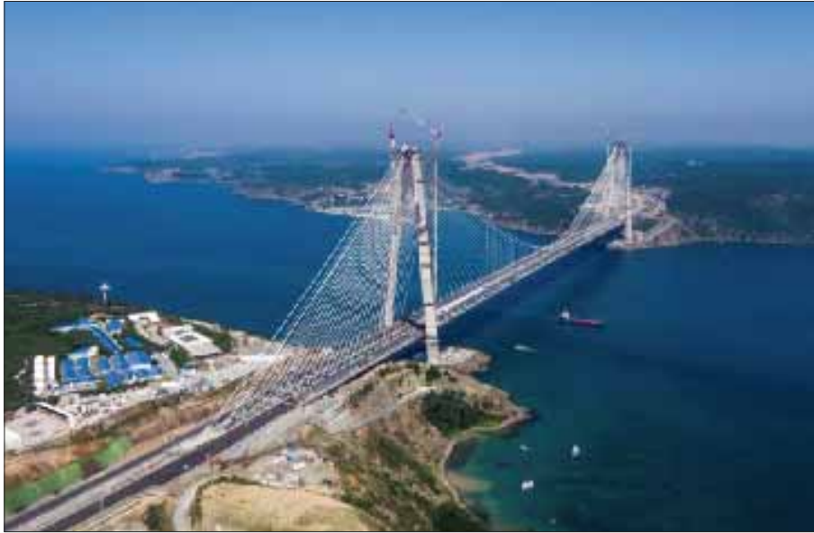
TURCHIA ASTALDI Terzo Ponte sul Bosforo
